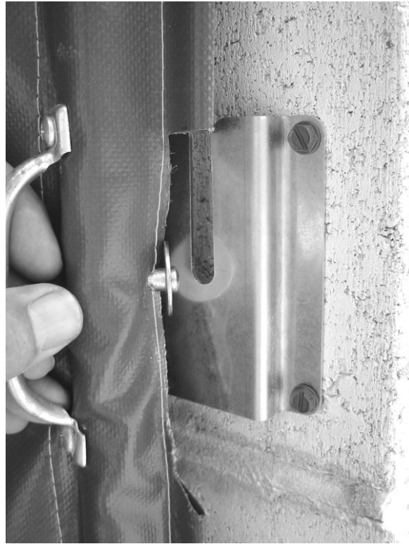
Foto #7 (Montaje del soporte de cerradura de ranura)
