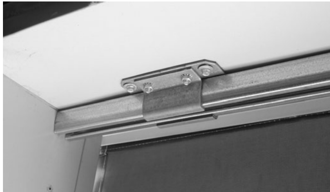
Foto #1 (Montaje de la pista y del empalme)
